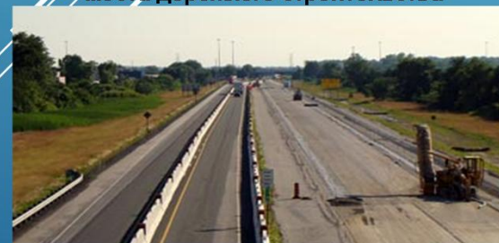
места дорожного строительства
